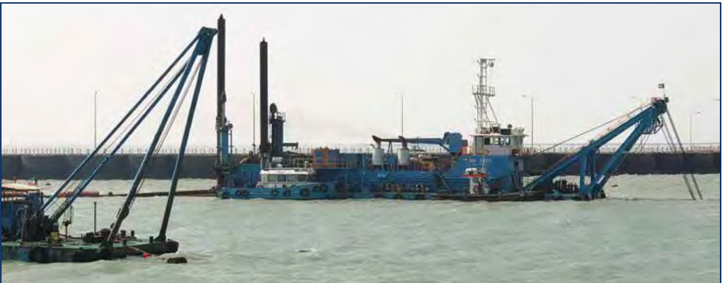
أعمال تطهير قناة مأخذ مياه البحر لمحطة الصبية لتوليد القوى الكهربائية وتقطير المياه
